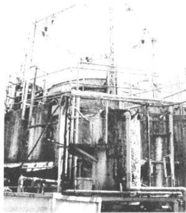
メタン発酵槽
